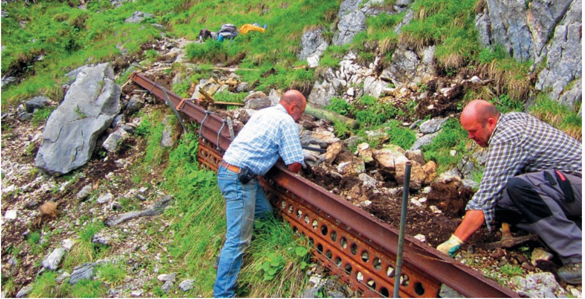
Beseitigungsarbeiten am Julius Mayr Weg
